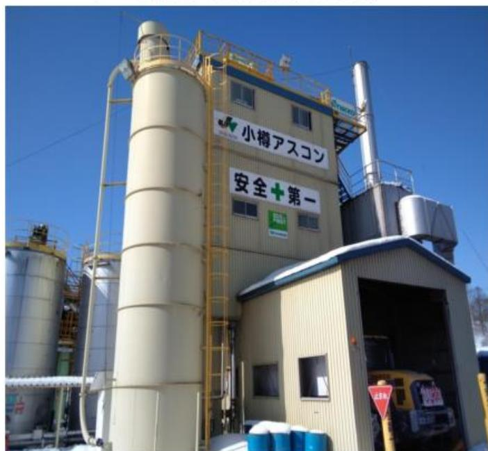
小樽市の家庭と飲食店から発生した廃食用油を北海道油脂事業協同組合が回収し、小樽市のアスファルトプラントに燃料として納入し、それを燃料としたアスファルト合材が出来上がり、そのアスファルト合材を使って小樽市の道路舗装に使う。小樽市で発生した廃食用油が最終的に小樽市内に還元され地産地消の構造をもたらす。今回のプロジェクトはこの実現に挑戦するものだ。すでに今年2月末にプラントへの供給が始まっており3月から実際に道路舗装への使用が開始された。
